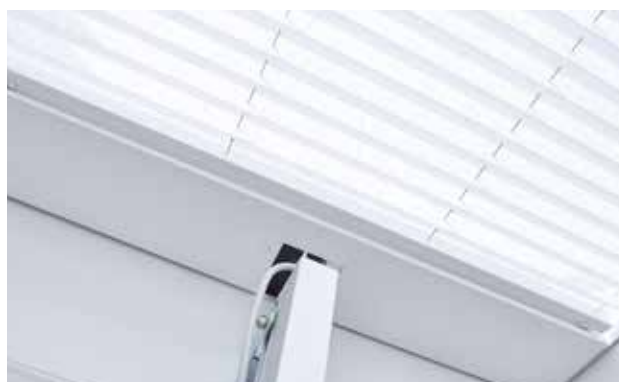
Flachdachfenster mit Linearantrieb und Blendschutz - Ansicht von unten
